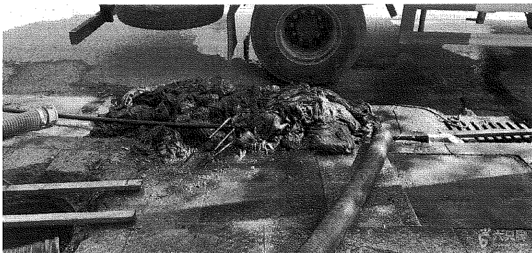
图 2. 管道淤积严重
